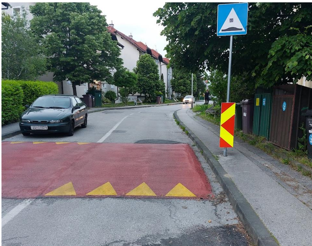
Načelni izgled izvedene uzdignute plohe (Zagreb)
