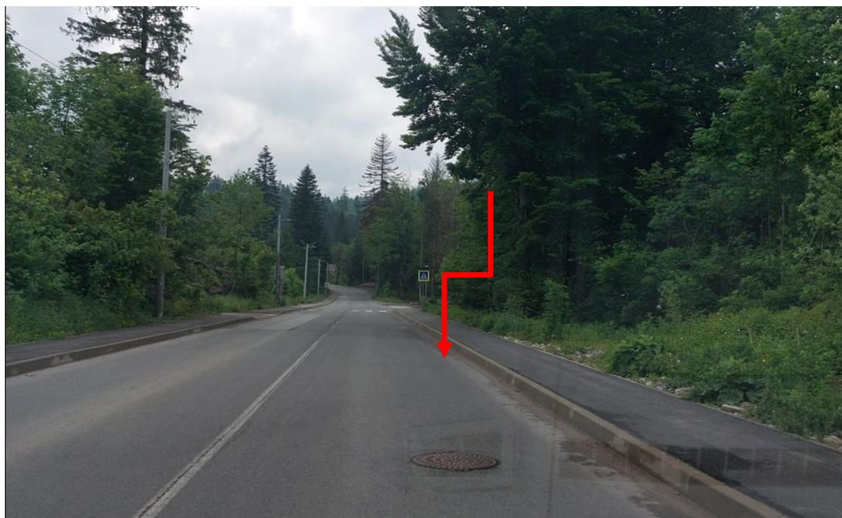
Pozicija 1. Pozicija uzdignute plohe prije postojećeg pješačkog prijelaza iz smjera Lučica (autocesta)
