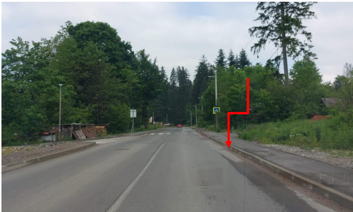
Pozicija 2. Pozicija uzdignute plohe prije postojećeg pješačkog prijelaza iz smjera pruge
