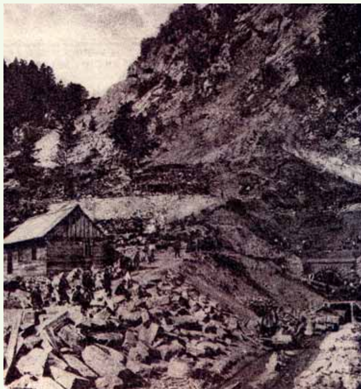
Fotografija prikazuje radove na probijanju najdužeg i najtežeg pothvata graditelja pruge Kupjačkog tunela na Riječko – karlovačkoj pruzi 1870. godine. Ulaz u tunela vidi se na slici dolje desno. Zahtjevno područje izgradnje Kupjačkog i Resnačkog tunela zabilježeno je i kao stanište zmija ridovki od čijeg ugriza radnici su smrtno stradavali.
