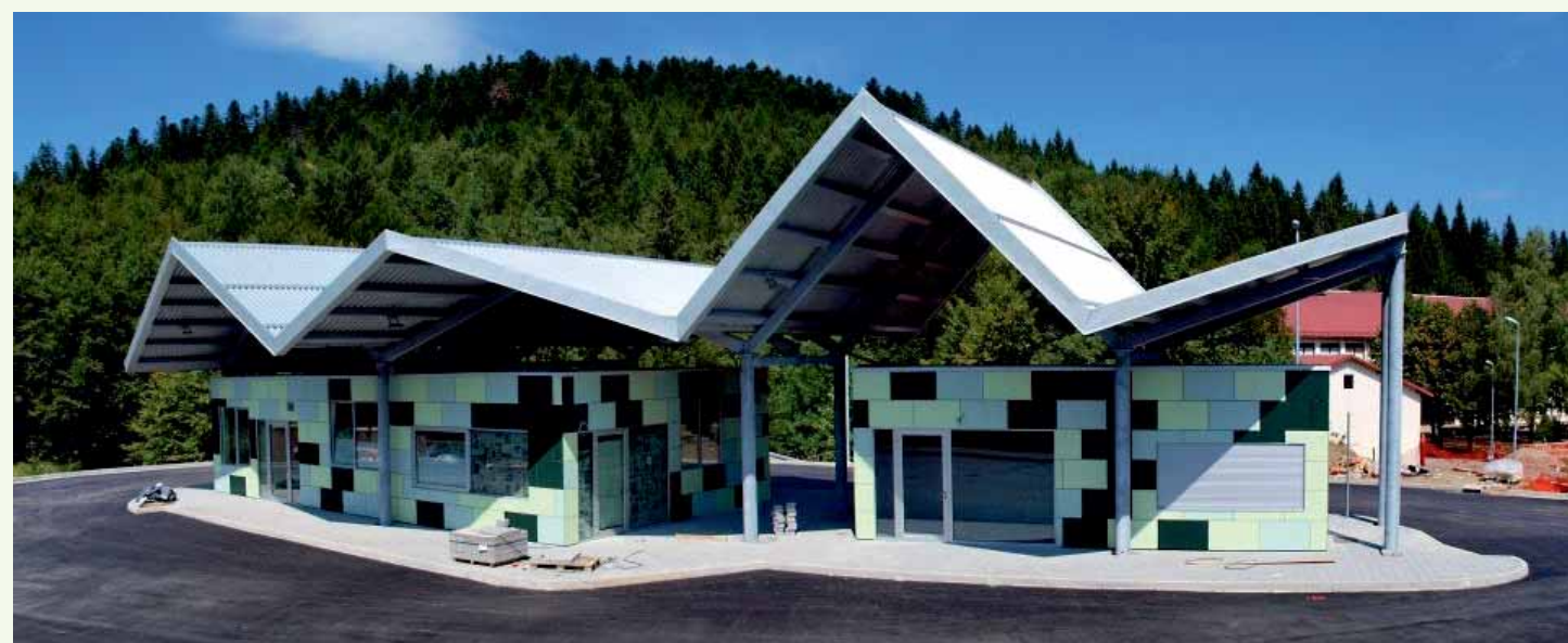
Novi Autobusni kolodvor u Delnicama izgrađen 2012. godine.
